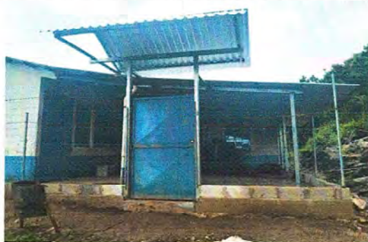
Foto 3: Colocada de puerta.
