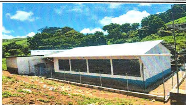
Foto 1: Canales y bajadas de agua pluvial instalados.
