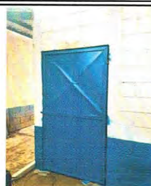
Foto 2: Colocadas de puertas de metal nuevas.
