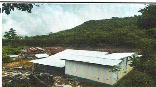
Foto 5: Cubierta de láminas nuevas.
